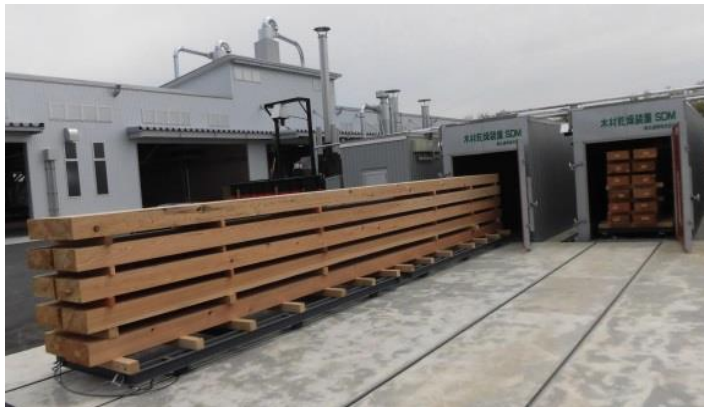
今年 5 月に完成した製材工場（手前の施設では長さ 10m の木材乾燥が可能）
