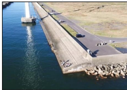
酒田港西護岸(全景)
