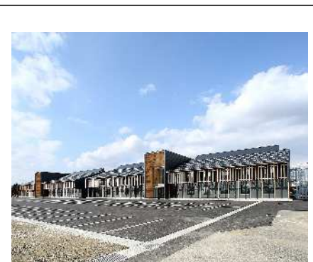
農業総合研究センター 園芸農業研究所 研究施設 【地方創生拠点整備交付金活用】
