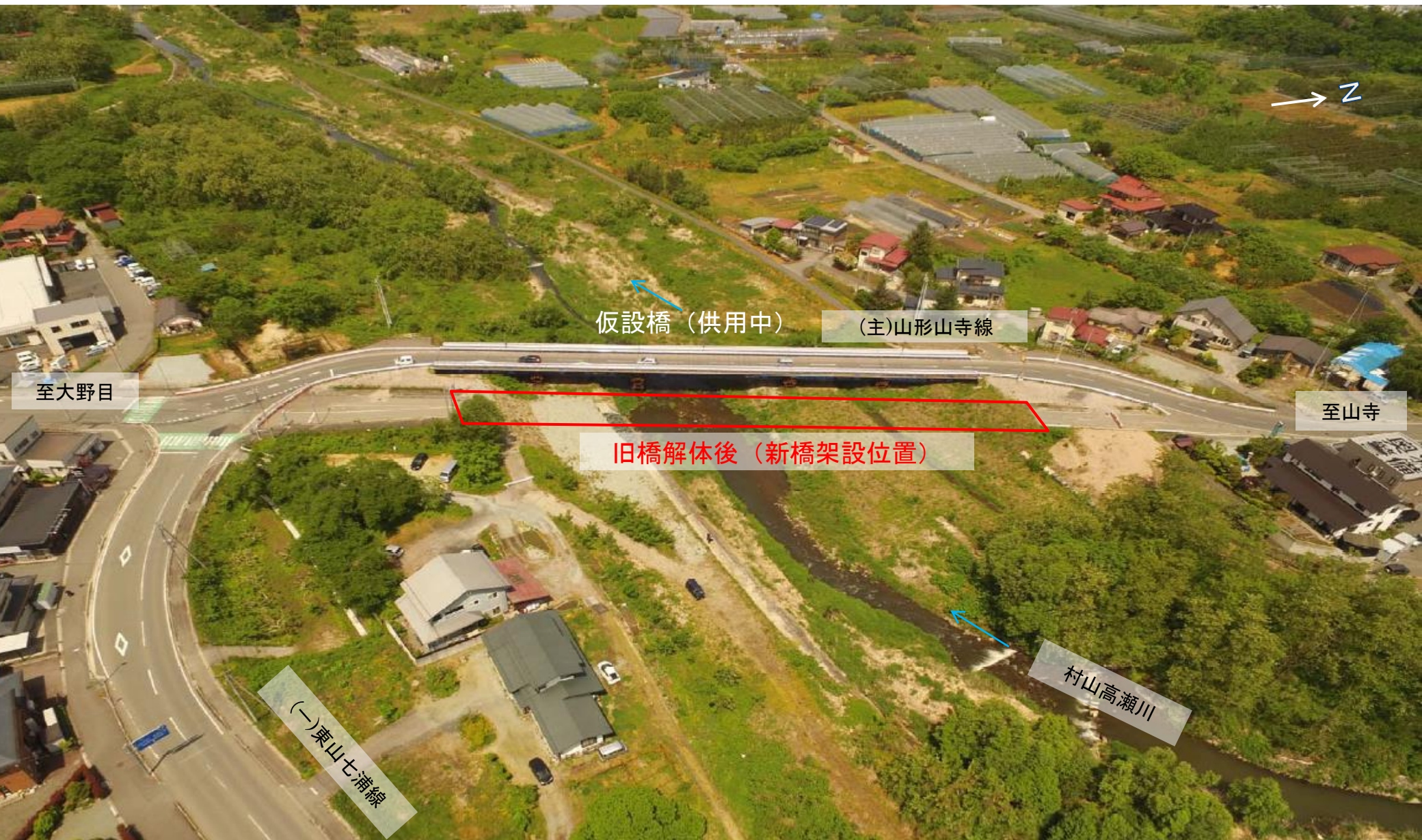
現在は旧橋撤去を完了し、今年度橋梁下部工着手予定（令和元年5月24日撮影）
