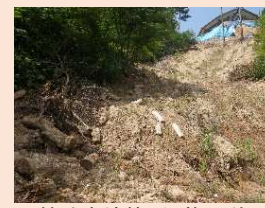
林地崩壊箇所 施工前
