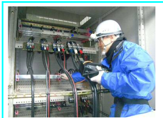
電気設備の点検
