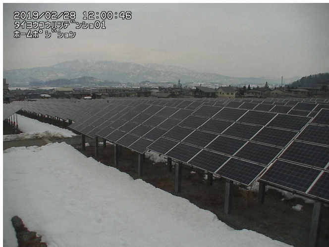
平成31年2月28日 12:00 太陽光発電所の状況
