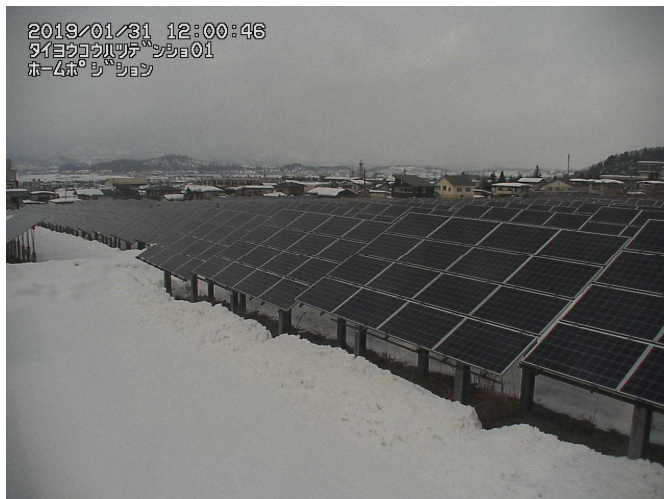
平成31年1月31日 12:00 太陽光発電所の状況
