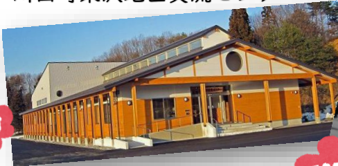
川西町東沢地区交流センター
