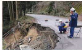
危険箇所での被災状況調査
