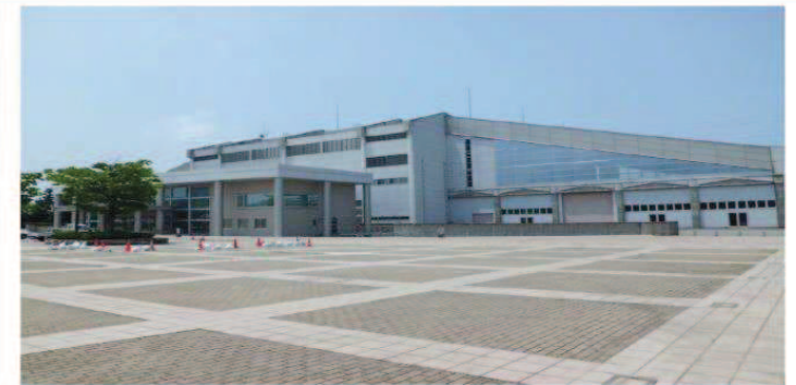
産業展示館4号館 外観
