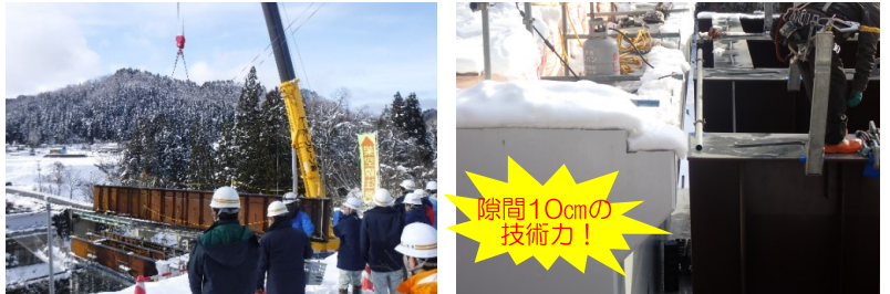
18.6tの橋桁吊り下げを見守る参加者（県、大江町職員等）
