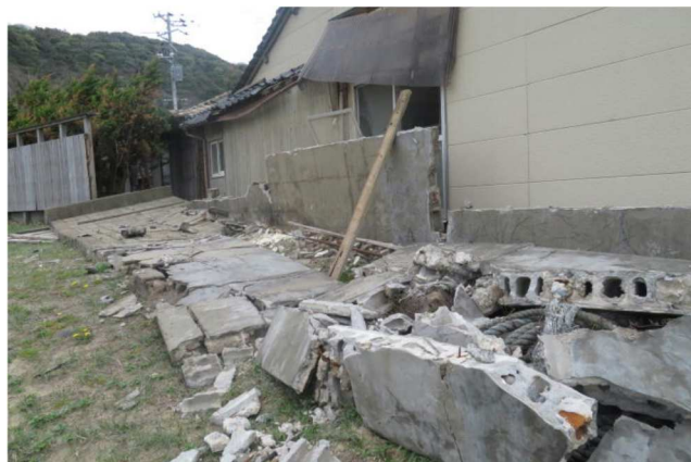
写真：被害状況（ブロック塀倒壊）
