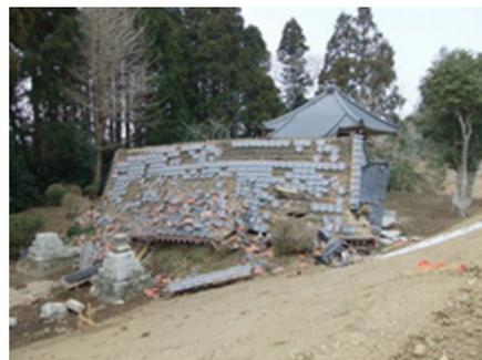
被災状況（木造建築物の倒壊）
