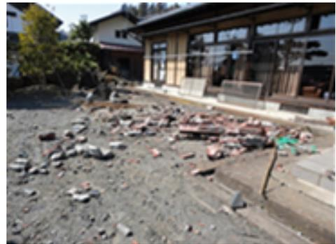
【写真4】被災状況(瓦の落下)
