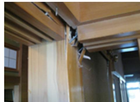
【写真8】被災状況(鴨居のずれ)
