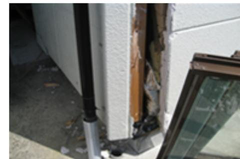
【写真7】被災状況(外壁のずれ)
