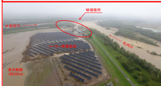
札内川の堤防決壊状況(帯広市)
