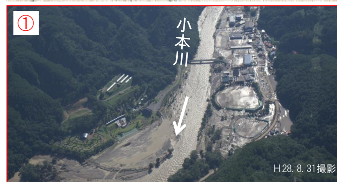
乙茂地区の被災状況
