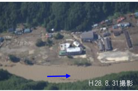
H28. 8. 31撮影 小本川 被害状況①
