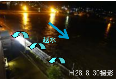
H28. 8. 30撮影 久慈川(右岸)越水状況
