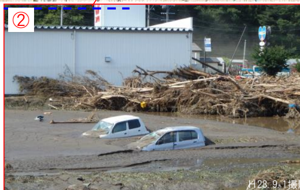
流入した土砂による車の埋没状況
