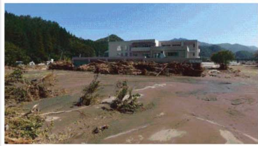
平成28年台風第10号による被害状況
