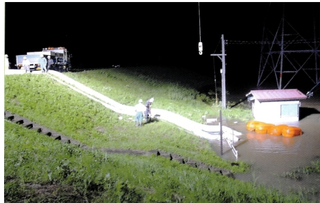
直轄による排水ポンプ車による内水排除状況
