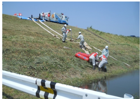
直轄での排水ポンプ車設置訓練状況
