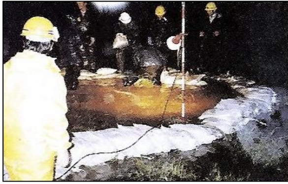
水防活動(釜段工)
