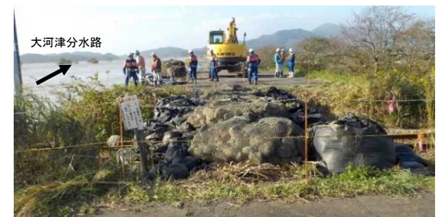
(右岸)土のう積 作業完了(燕市)
