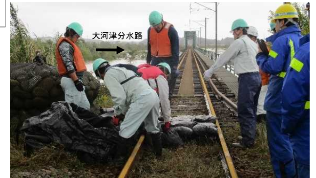
(右岸)土のう積 作業状況(燕市)
