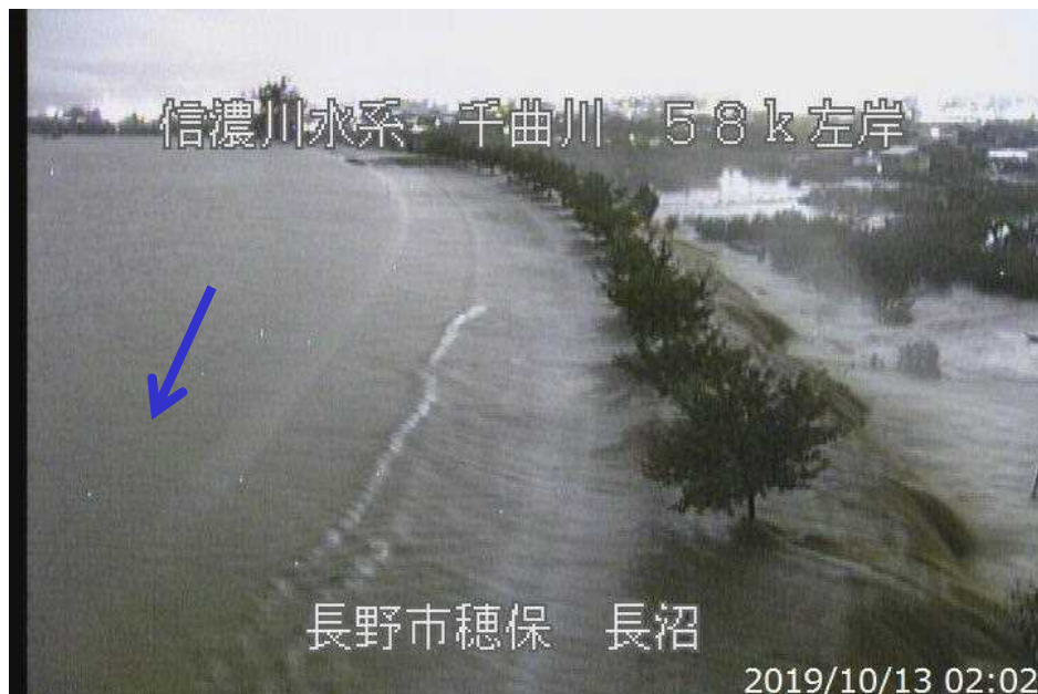
越水状況(10月13日2時頃)
