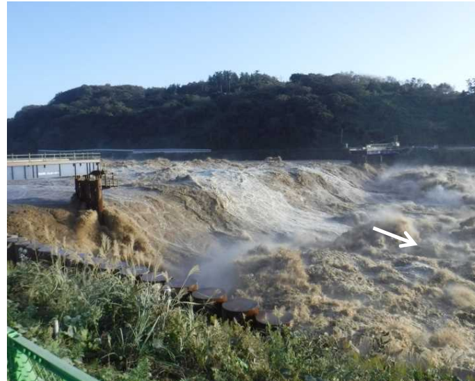
第二床固副堰堤付近の状況 (10月13日16時06分時点)
