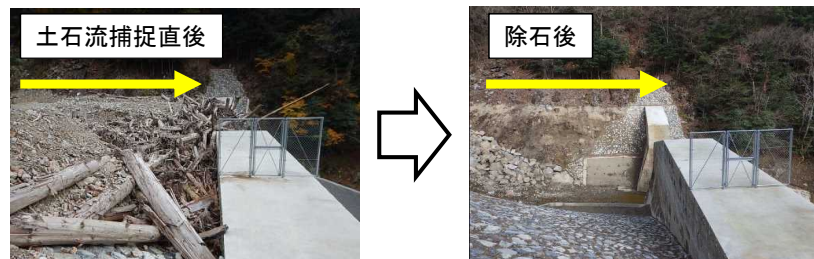
砂防堰堤の除石事例
