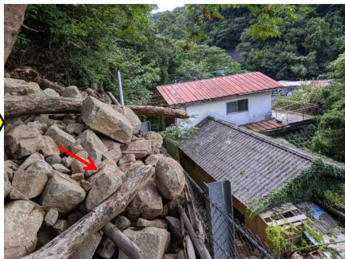
土砂捕捉状況
