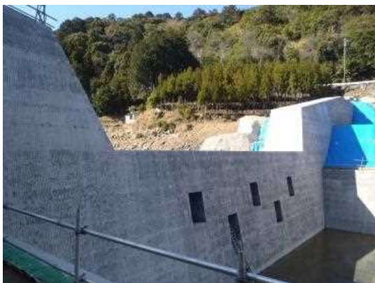
不透過型砂防堰堤
