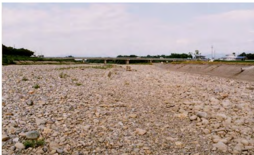
写真 5 鬼面川大樽橋付近の河川の状況(H12.8)
