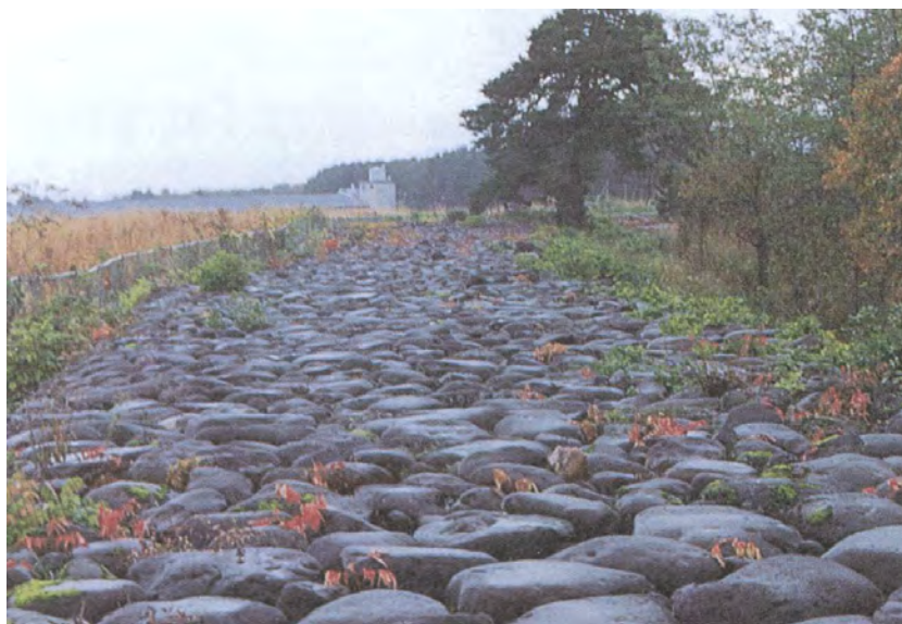
写真 3 直江石堤（米沢市赤崩地区）
