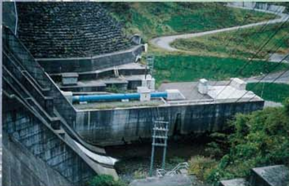
月光川ダム発電所
