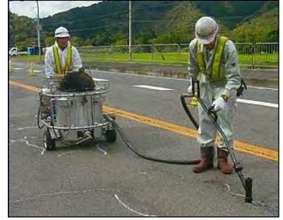
写真. シール材注入工法（施工中）
