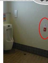
▲各個室、出入り口付近、奥の壁際に緊急時の呼び出しボタンを設置した事例
