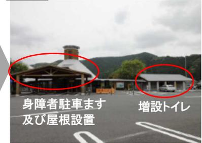
▲身障者用駐車ます屋根を設置し、増設されたトイレ棟とも屋根付き通路で連結した事例
