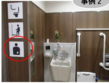
▲男女の個室に1箇所オストメイト対応器具を設置しピクトグラムで表示した事例
