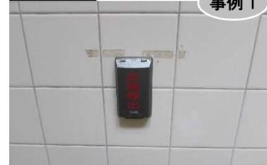
▲緊急時呼び出しボタンの使用方法が剥がれている事例
