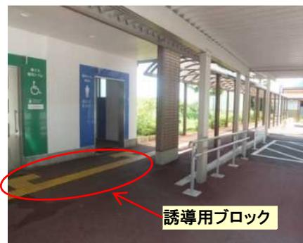
▲駐車場からトイレまで屋根を設置し、段差をなくすように改修した事例
