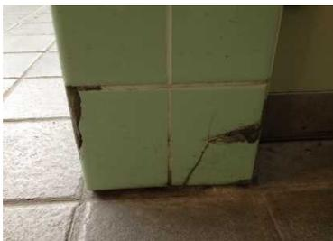
▲タイルの損傷事例
