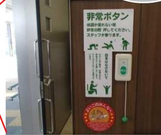
▲転倒時でも使いやすい位置に緊急時の呼び出しボタンを設置した事例
