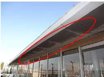
▲雨水が軒裏に漏水した事例
