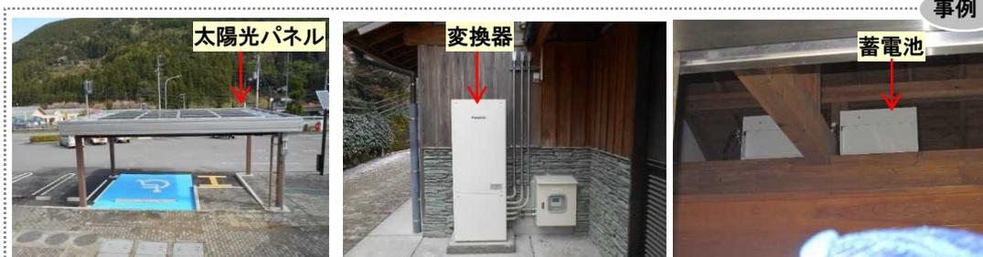
▲災害時に必要な電源を確保した事例(太陽光発電により蓄電)
