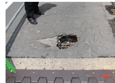
▲ 床板の抜け落ち ((主)大石田畑線 亀井田橋)
