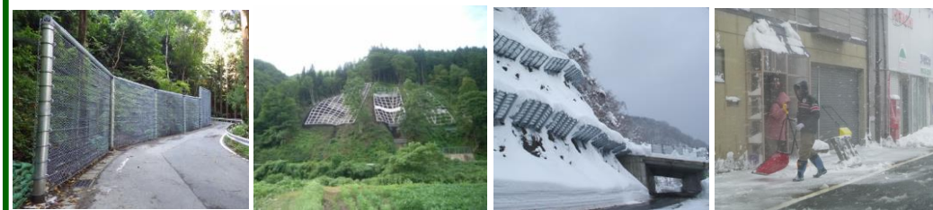
▲防災対策(例) 左:(主)上山七ヶ宿線 (上山市) 落石防護柵 右:(主)余目温海線 (鶴岡市) 法面保護工 ▲冬期間の交通安全対策(例) 左:(国)344号 (真室川町) 雪崩予防柵 右:(一)大石田名木沢線 (大石田町) 流雪溝
