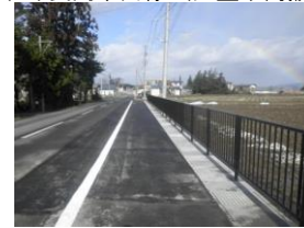
▲幅広路肩による歩行空間の創出 (国)287号 (川西町上小松)
