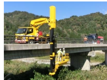
▲ 橋梁点検実施状況
