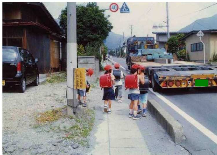
▲歩道及び路肩拡幅 前
