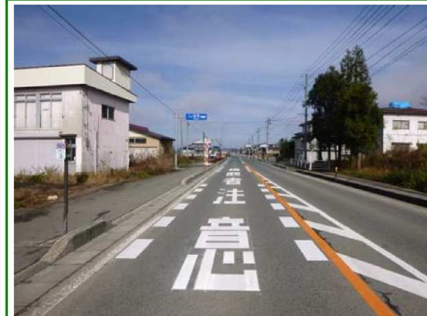
▲注意喚起の路面標示
