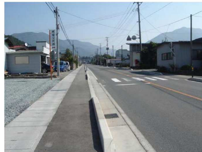
▲歩道及び路肩拡幅 後
