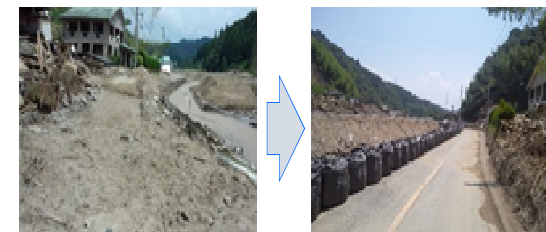
災害時の道路啓開
