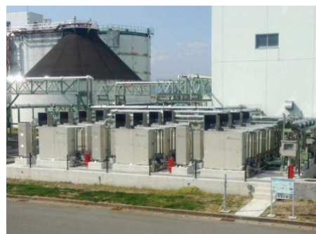
山形浄化センター
