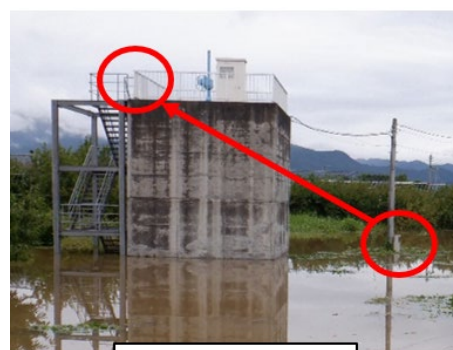
浸水のおそれのある 受電盤の移設
