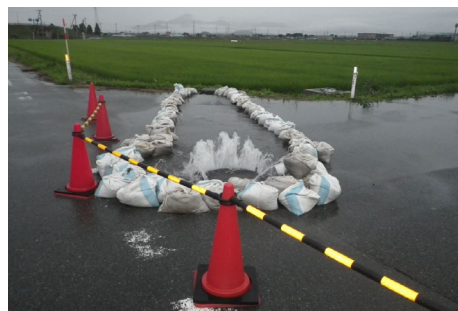
マンホールからの溢水状況(天童幹線)
