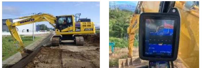
ICT活用工事の施工例 (3次元データを活用した盛土工事)
