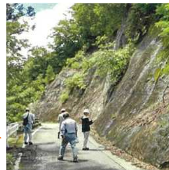
施設点検への活用(法面)
