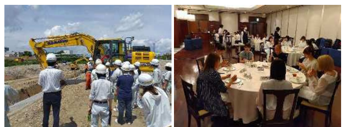
先進的な建設現場の見学会や技術者との意見交換会を開催
