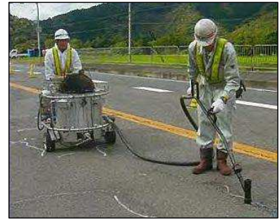
写真. シーラ材注入工法（施工中）
