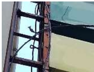
異常箇所（ナットの欠落）
