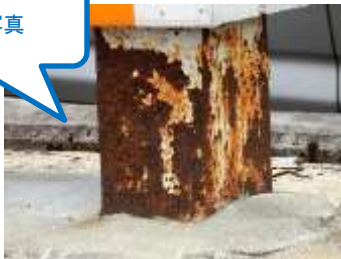
異常箇所（支柱にサビがあった）
