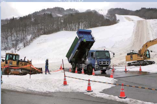
①ダンプで雪を運び入れ、ショベルで均す。
