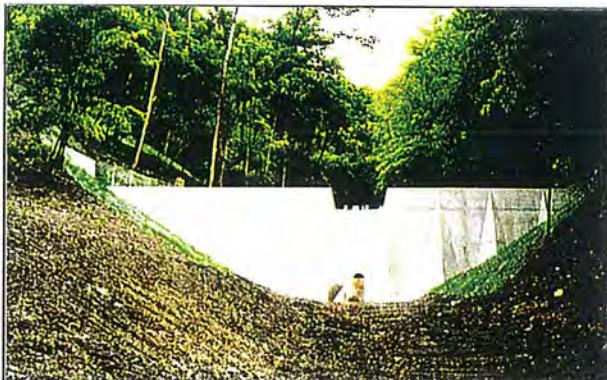
壁面に支壁を張り出すことによって、構造的な合理性を追求しつつ、単調になりがちなダム下流面に表情を与えていた。コンクリート製のダムの設計にあたっては、求められる機能や構造上の合理性を満たしたうえで、形態そのものを洗練することが重要となる。
