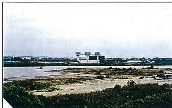
門柱の太さや門扉の面積等に配慮しながら、施設全体として一体的にデザインし、大規模になりがちな印象を抑えている。また、門扉には門柱のコンクリートと同程度の明度の色彩を用いているため、施設としてのまとまりを感じさせ、さらに河川環境にも溶け込んだ状態となっている。
