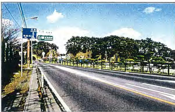
景勝地に設置された防護柵。細い部材を用いたガードパイプ型のため、透過性が高く、さらに、塗装色に低彩度のブラウン系の色を用いているため、背後の駐車場のフェンスや周辺の樹林に溶け込んでいる。（宮城県 松島町）
