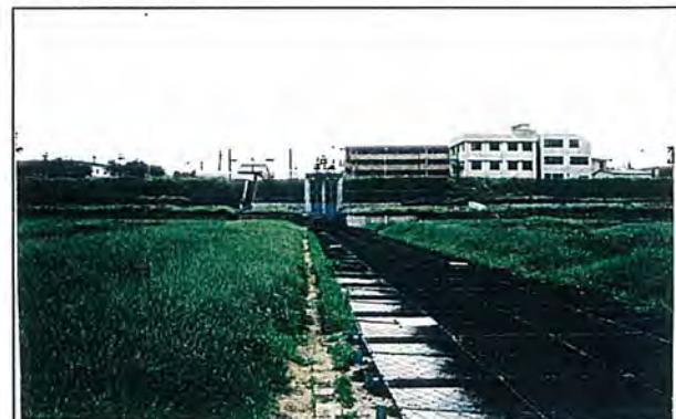
樋管自体の規模は小さいが、門扉に用いられた彩度の高いブルー系の色は、河川空間において目立つ存在となっている。また、取り付け護岸の連接ブロックが、周囲の緑化された堤防に対して人工的な印象を与えている。
