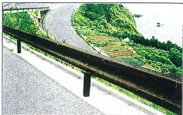
幅の広いビームに低彩度、低明度のブラウン系の色を塗装しているため、道路景観での存在感が強い。また、樹皮を模した凝った塗装方法を用いているが、あまり効果的ではなく、かえって不自然な印象となっている。
