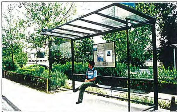
周辺を緑地に囲まれたバスベイ。壁面に透過性の高い素材を用い、部材を細くしたうえで、明度の低いグレー系の色を選択しているため、周辺の緑地に溶け込んでいる。
