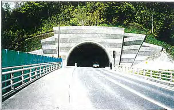
面壁を複数の壁面で構成することにより、平面的になりがちなトンネル面壁に立体感を与えていた。また、面壁表面に交互に方向を変えながらスリットを入れることによって、微妙な陰影を生み出し、実際には単色のコンクリートを、2種類のグレーを用いているように見せる効果をもたらしている。
