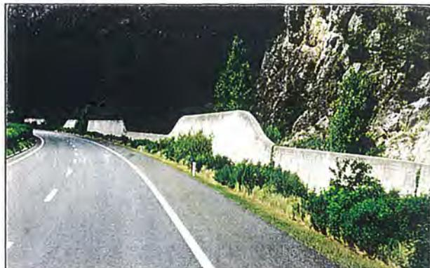
落石対策の道路擁壁。高さの異なる擁壁が、なめらかに連続しながら設置されているため、全体的に一体感のある印象となっている。ただし、壁面全体の明度が若干高いため、樹木や岩肌等の自然的な周囲の環境から浮き上がった印象となっている。（スイス）
