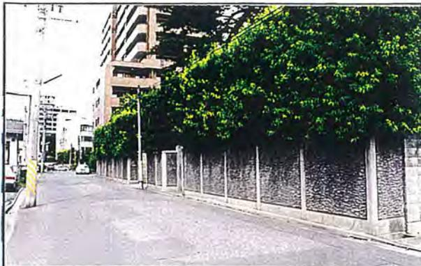
コンクリート壁の表面処理の一例。壁面を一定の間隔で分割することによって、単調になりがちな壁面にリズムを与えていた。そのうえで、表面処理を行うことによって、陰影による表情を与えていた。
