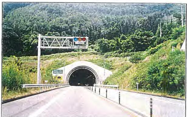
入り口部を段階的に後退させて陰影を与え、トンネル入口を広く見せる効果を生み出している。さらに、面壁の形状に曲線を導入することによって、周辺の地形に馴染ませるよう工夫を施している。また、面壁下部のスリットにより、近くから眺められる場合に表情が感じられるよう配慮されている。
