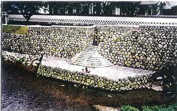
河川に設置された石積護岸。護岸下部に大きな石を用い、上部にはより小さな石を用いることによって、護岸全体に安定感を与えていた。また、少しずつ色味の異なる石を用いて、護岸に適度な変化と表情を与えていた。
