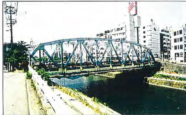
都市内河川に設置された橋梁。部材の幅が広くなるため、重い印象となりがちな構造の橋梁を、軽快に見せるために、部材の下部から上部に向かって明度を高めているが、かえって繁雑な印象を強めている。一本の部材で色を塗り分けることは、メンテナンス等に手間がかかるため、避けた方がよい。
