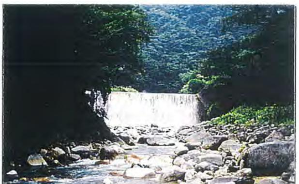
山間部に設置されることが多い砂防ダムは、一様な壁面として唐突に自然環境の中に現れることとなる。自然素材である石材は、人工的な印象の強いコンクリートに比べて自然環境に馴染みやすいため、周辺の状況によっては石材を用いることも考えられる。
