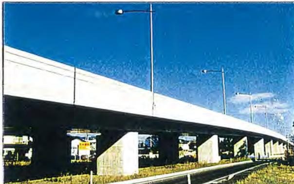
コンクリートを用いた道路橋。橋桁に張出ウェブを用いて陰影をもたせることで、重い印象となりがちな桁幅を薄く、軽快に見せている。また、照明柱には細い部材を用いて橋梁本体と一緒にデザインを行い、コンクリートに近いグレー系の色を用いているため、橋梁全体に統一性が感じられる。(福島市)
