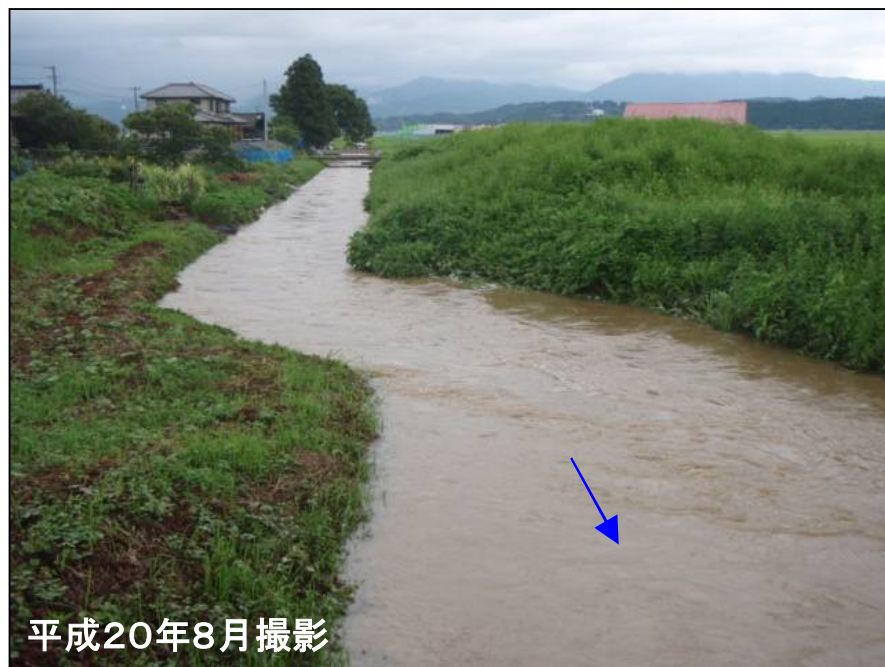
改修前 Q=16\text{m}^3/\text{s}
