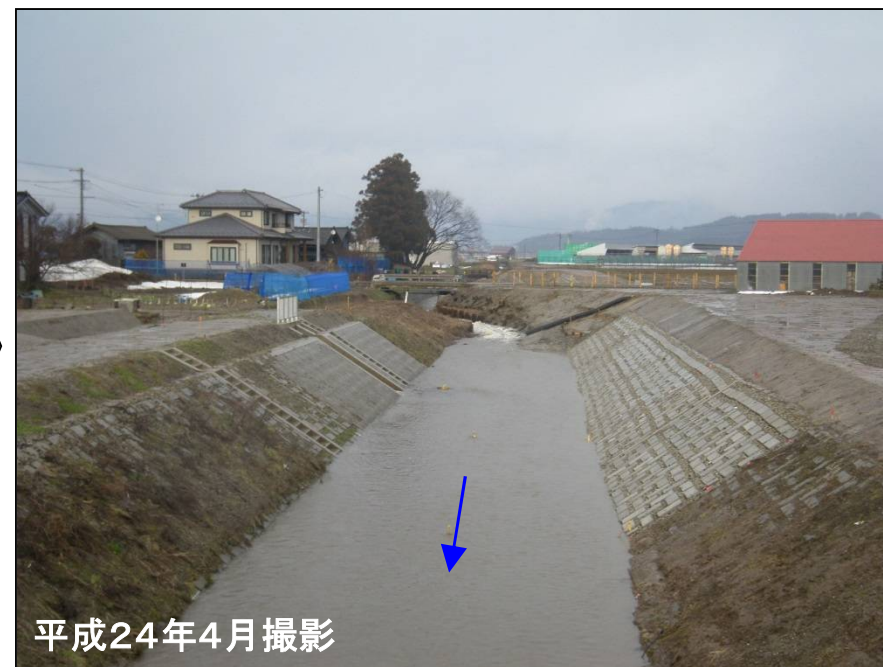
改修後 Q=50\text{m}^3/\text{s}
