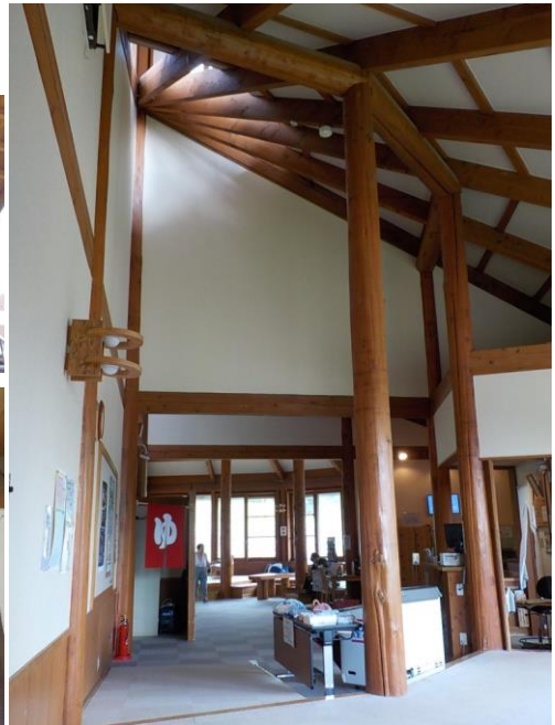
施設内部丸太利用状況
