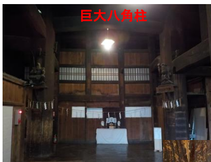
施設内の囲炉裏の煙が柱の劣化を防ぐ
