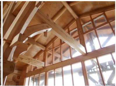
中上、右上: 玄関ホール(太鼓落し+根曲材利用+大きな面取り)
