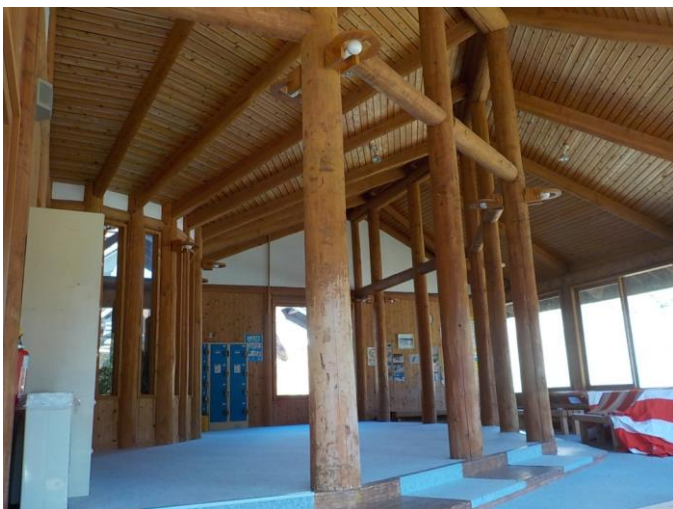
施設内部丸太利用状況
