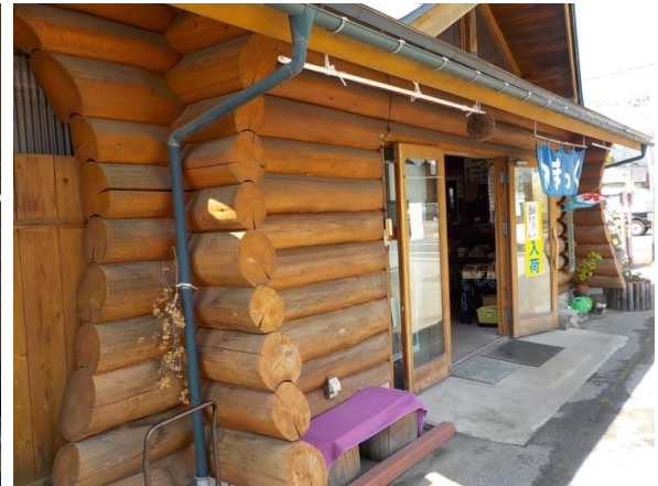
外構部スギ丸太状況
