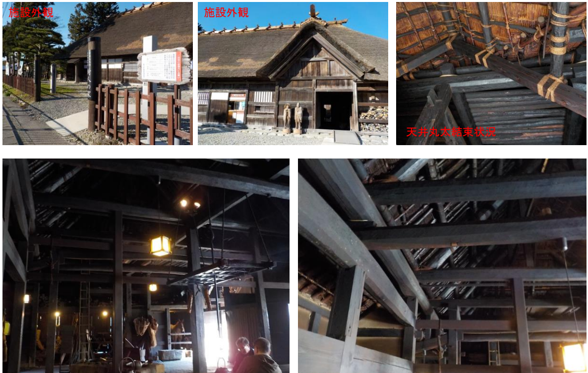
施設内部丸太利用状況(松材梁、囲炉裏の煙が木の劣化を防ぐ)
