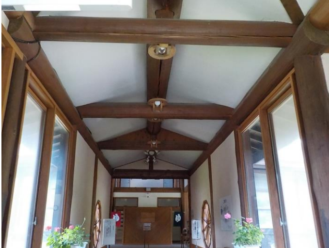
施設内部丸太利用状況(入口～浴場)
