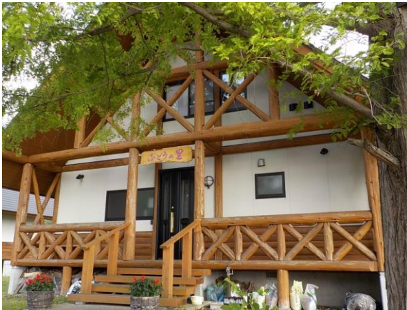
施設丸太利用状況(柱・梁等に丸太を大量使用)景観的にも美しい
