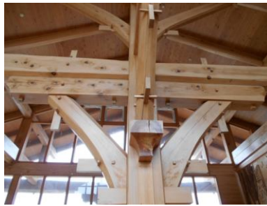
中上、右上: 玄関ホール(太鼓落し+根曲材利用+大きな面取り)
