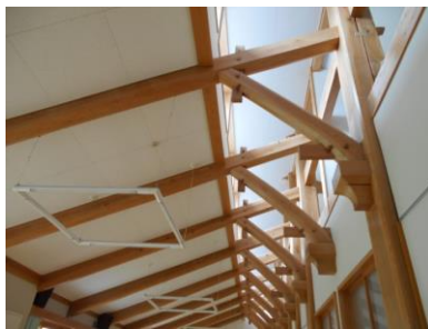
下写真: 特徴ある建築デザイン、根曲り材を法杖や筋交的に利用、太鼓落し材が多い
