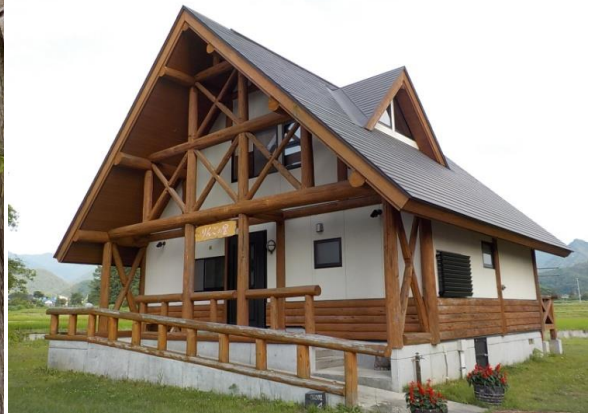
施設丸太利用状況(柱・梁等に丸太を大量使用)景観的にも美しい
