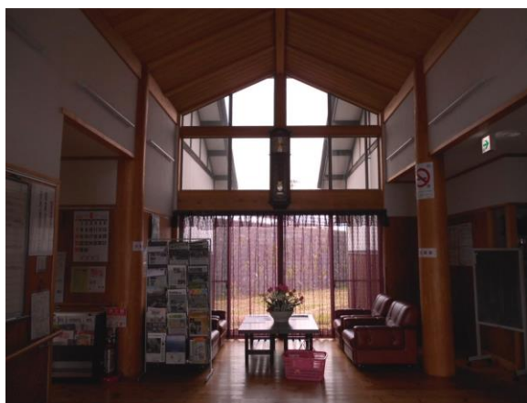
砂越ミセン 丸太利用状況 (丸太柱に割れなし)
