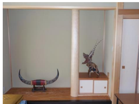
施設内装(磨き丸太使用状況)
