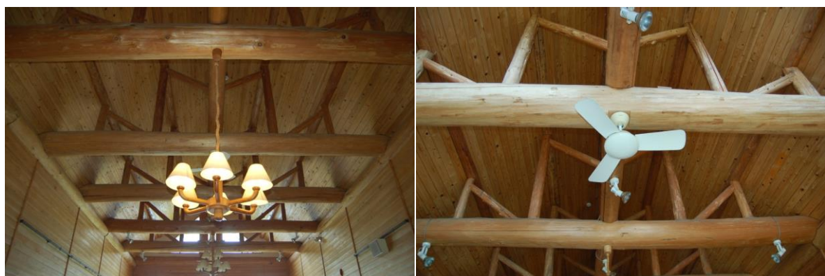
施設内丸太利用状況(杉の梁丸太が美しい)
