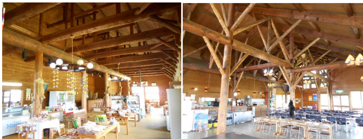
施設内丸太利用状況(売店、レストラン内の柱と梁が丸太、良い雰囲気)
