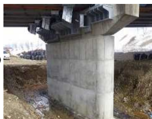
対策後(橋脚巻立)
