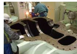
県営事業で対応したポンプの補修
