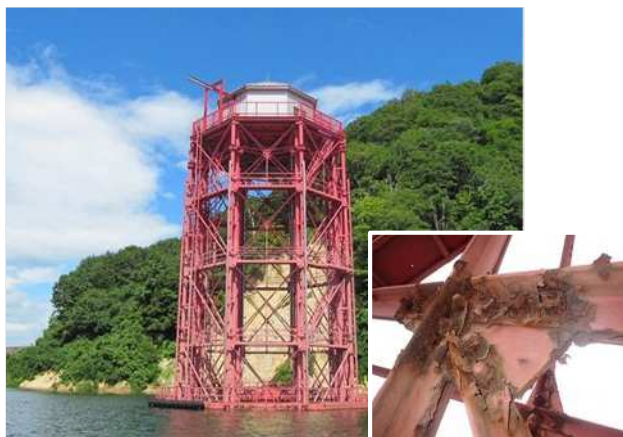
大規模で高度な技術による本格的な改修が必要な施設 S54 造成 犬川黒川取水塔（飯豊町）
