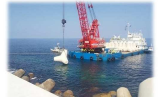
消波ブロック据付状況
