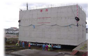
ケーソン進水状況
