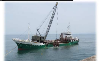
ガット船の基礎捨石投入状況
