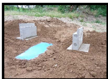
①橋台の設置
