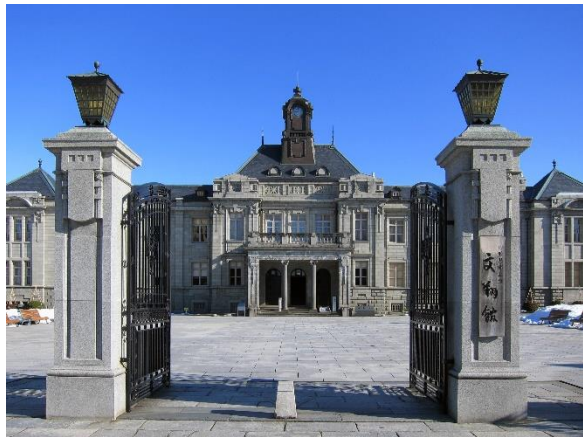
▲旧県庁舎 郷土館として公開しています
