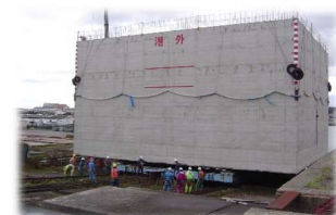
ケーソン進水状況
