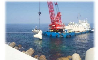
消波ブロック据付状況
