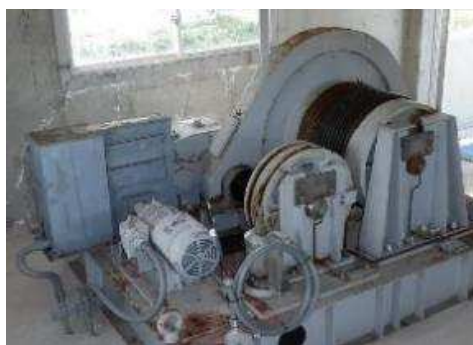
機械設備の補修
