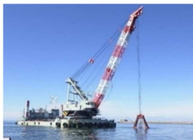
②酒田港の浚渫工事状況
