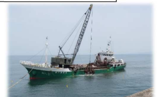
ガット船の基礎捨石投入状況
