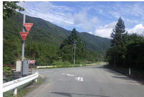
【Aから見た本件事故現場の状況】
