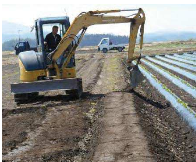
バックホウによる 復田の畦畔かさ上げ
