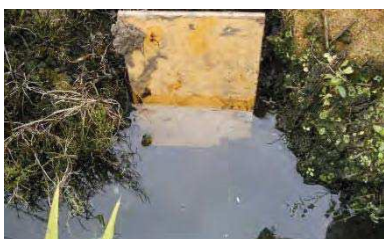
止水板による止水状況
