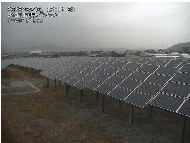
令和4年5月31日 12:11 太陽光発電所の状況
