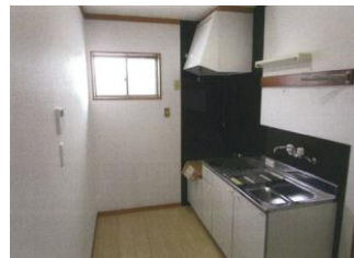
改修後 キッチン
