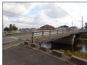
▲苗津新橋 全景
