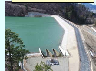
老朽ため池の改修例
