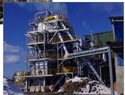
バイオマス発電施設
