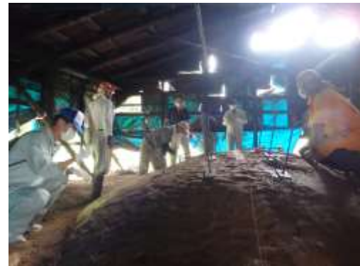
黒炭窯の天井づくり③ 上部の土は木のヘラで 叩きながら形を整える
