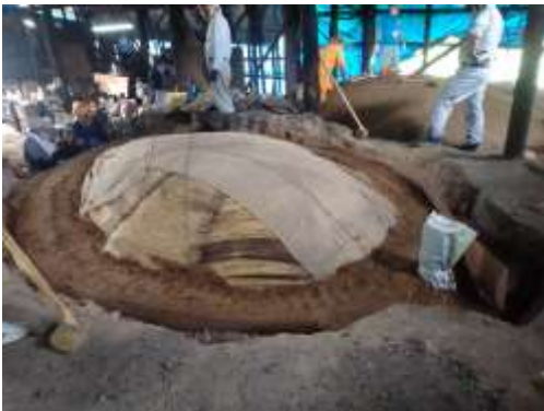
黒炭窯の天井づくり② 周囲から土を積み上げ 木槌で打ち固める
