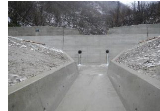
【治山:溪間工(治山ダム)】
