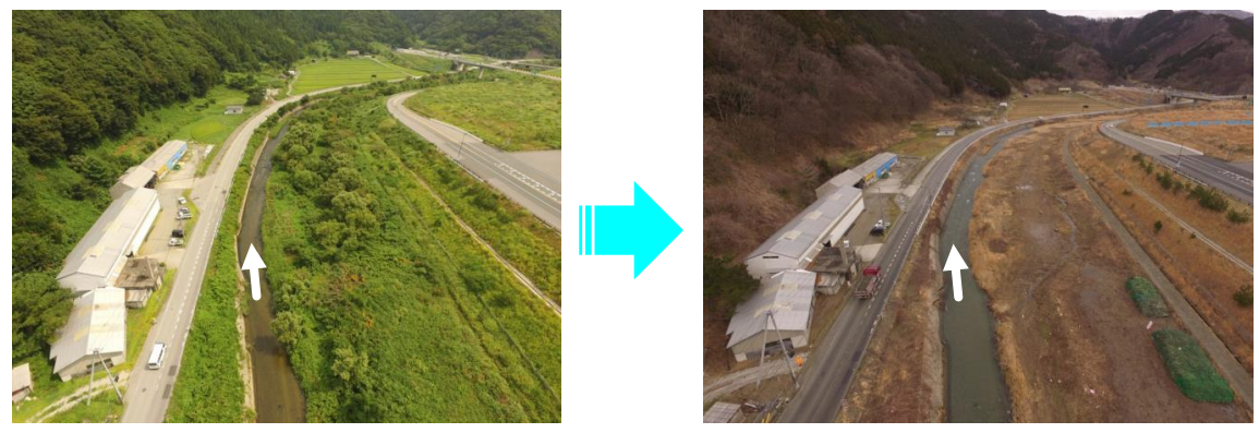
▲ 庄内小国川(鶴岡市) 令和元年度実施 支障木伐採
