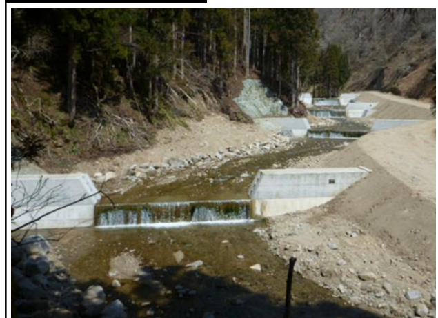
渓床の安定化を図る治山ダム
