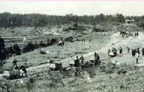
↑当時の工事の様子 (上下共 写真提供 尾花沢市)
