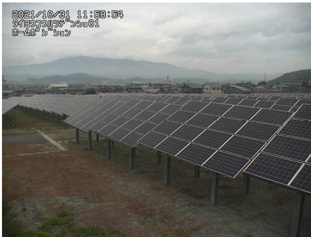
令和3年10月31日 12:00 太陽光発電所の状況
